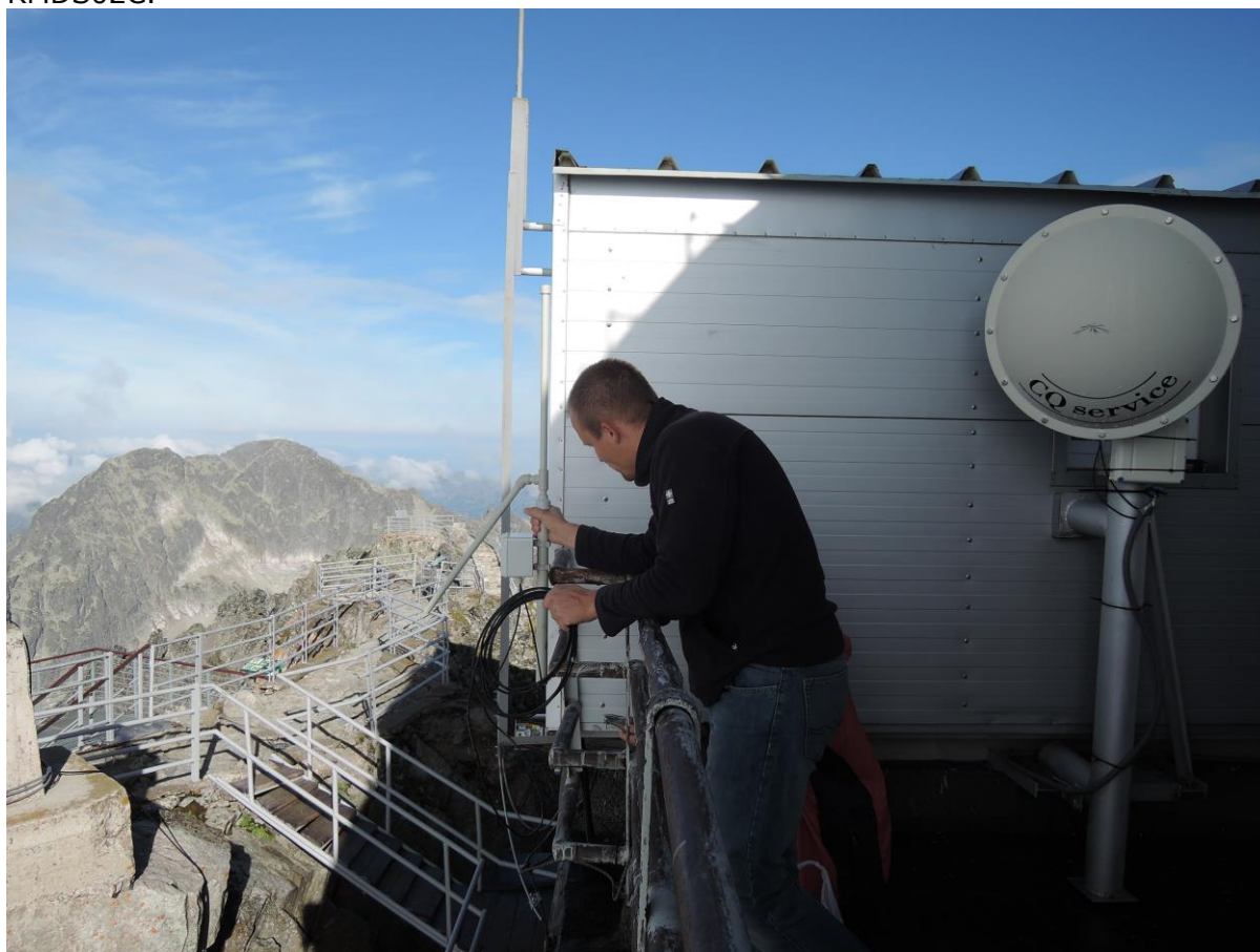
Obr.: Instalace antény na Lomnickém štítu
